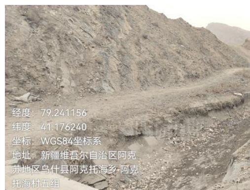
未硬化灌渠现状
