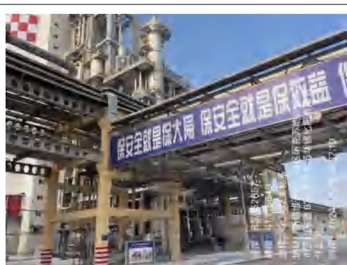
原料液氨、二氧化碳输送管线（架空）
