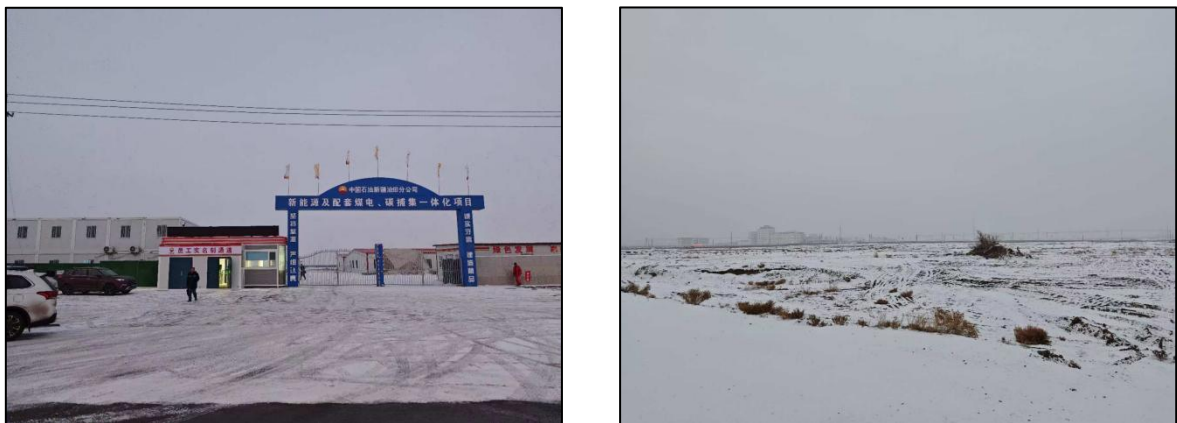
图 3.2.4-1 750kV 接入站现状照片
